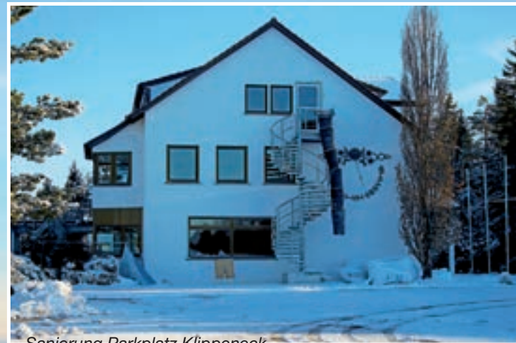
Sanierung Parkplatz Klippeneck
