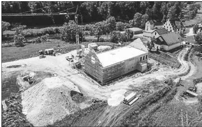
Luftaufnahme Neubau Wasserwerk Beuron-Langenbrunn
